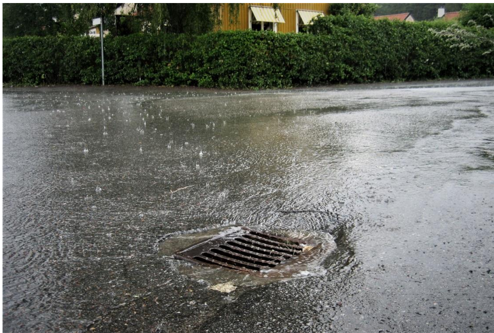
Bild ovan: Regnvatten i dagvattenbrunn.
